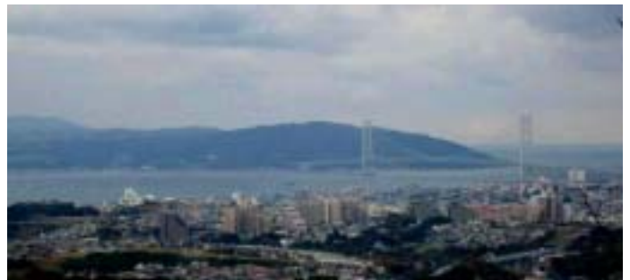
明石海峡・明石大橋
