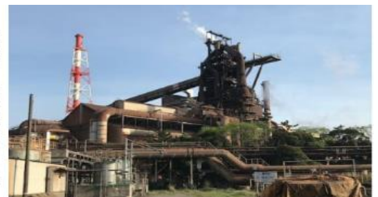
JFEは鋼材値上げを進める(JFE スチールの製鉄所)
