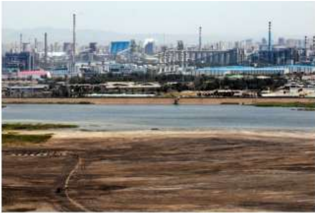
中国・包頭市にある、部分的に水がたまった面積4平方マイルの人造湖。レアアースや鉄鉱石の処理で生じた有毒な廃棄物が投棄されているが、地下水への漏出を防ぐシートは設置されていない＝2025年4月、ニューヨーク・タイムズ
