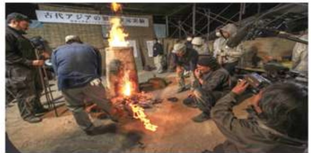
古墳時代の製鉄炉の復元（アジア産業考古学研究センターと 韓中国新見庄たたら伝承会とのコラボレーション）
