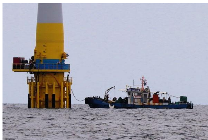
現場海域ではケーブル挿入作業が行われていた。
