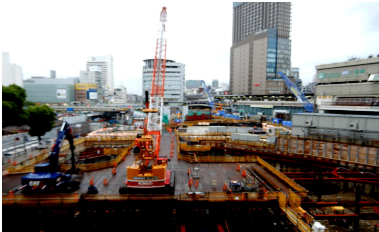
神戸市の市街地の大改造 三ノ宮駅前の工事の写真
