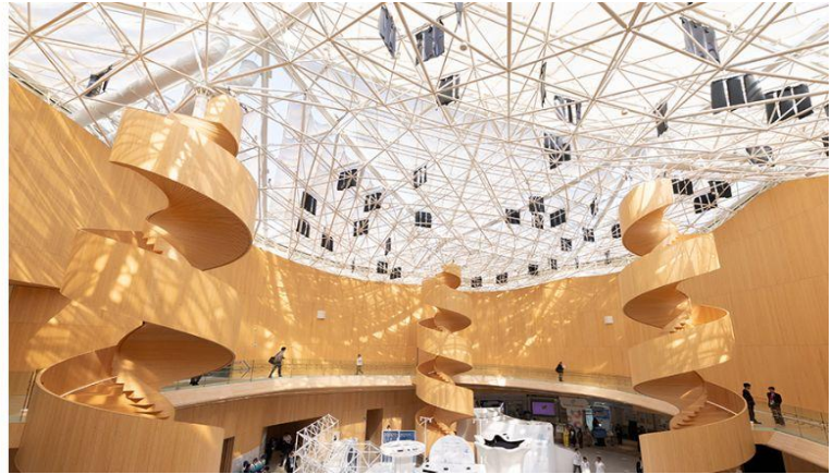
左) 万博内スマートホールに設置されているフィルム型ペロブスカイト太陽電池 (写真提供: 関西電力送配電)
