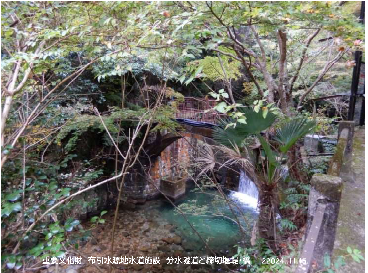
重要文化財 布引水源地水道施設 分水隧道と締切堰堤・橋 22024..11.15.
