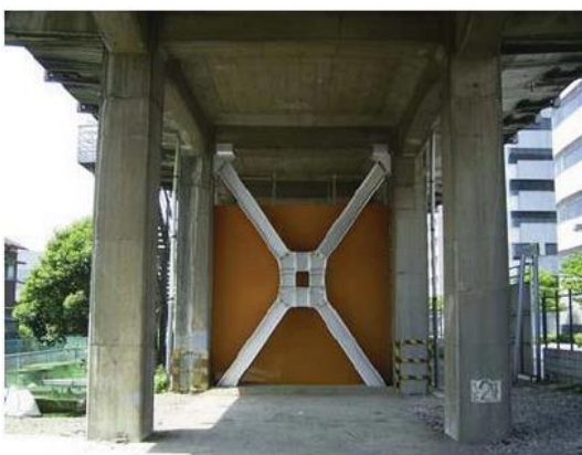
高架橋への取り付け例
