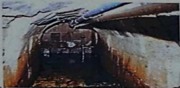
分水堰堤でせき止められた水を、布引ダムへと導水するためのトンネルです。拱台内の井を開閉することによって、必要な水量をダムに流すことができます。硬い岩盤を25mくりぬいて造られており、入口と出口の一部には石が張られています。
