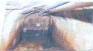
分水堰堤でせき止められた水を、布引ダムへと導水するためのトンネルです。拱台内の井を開閉することによって、必要な水量をダムに流すことができます。硬い岩盤を25mくりぬいて造られており、入口と出口の一部には石が張られています。
