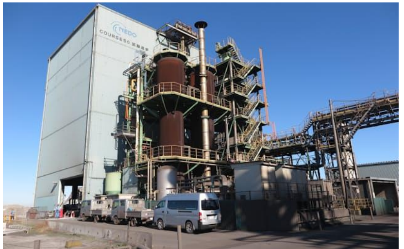
高炉水素還元技術の開発を進める試験炉(千葉県君津市)
