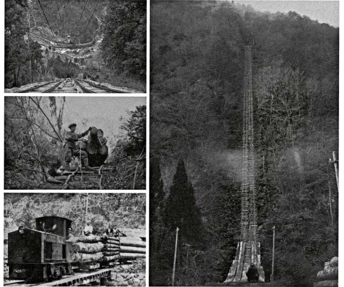
左上 写真 81 万ヶ谷索道 (堀田雄氏提供) 右 写真 84 音水インクライン (川原嘉之氏提供) 左中 写真 82 赤西木馬(きんま)作業 (西田マツヨ氏提供) 左下 写真 83 赤西国有林から貯木場へ向かう機関車 (橋元利之氏提供)
