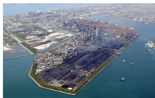
JFE は高炉 1 基を電炉に転換する方針だ (西日本製鉄所倉敷地区)
