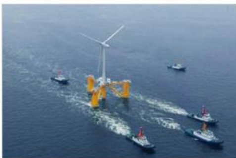
浮体式洋上風車の曳航
