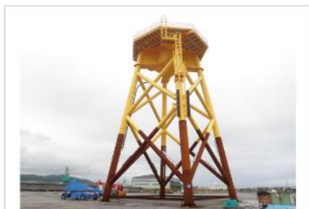
NEDO着床式洋上風力発電システム実証研究（ハイブリッド重力式基礎）
