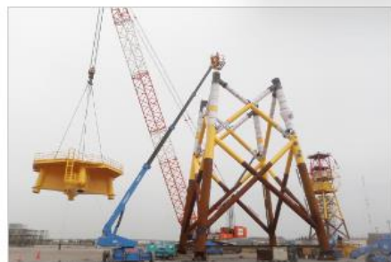
NEDO着床式洋上風力発電システム実証研究（ハイブリッド重力式基礎製作の様子）
