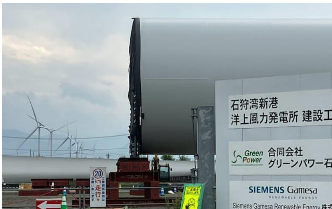
石狩湾新港では洋上風力発電所の建設が進む
