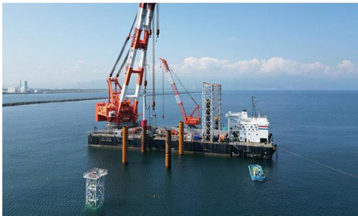
【石狩湾新港／現地海域での鋼管杭打設状況】
