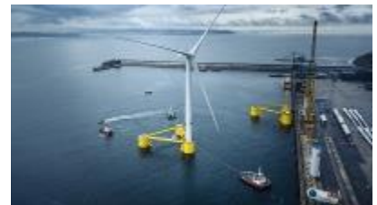
プリンシプル・パワーの浮体構造
