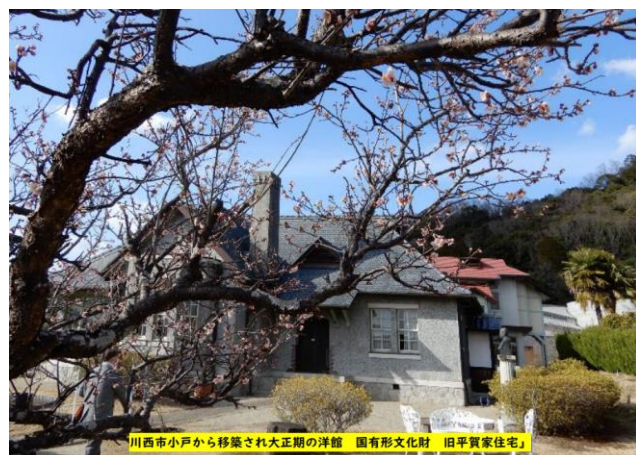
川西市小戸から移築され大正期の洋館 国有形文化財 旧平賀家住宅
