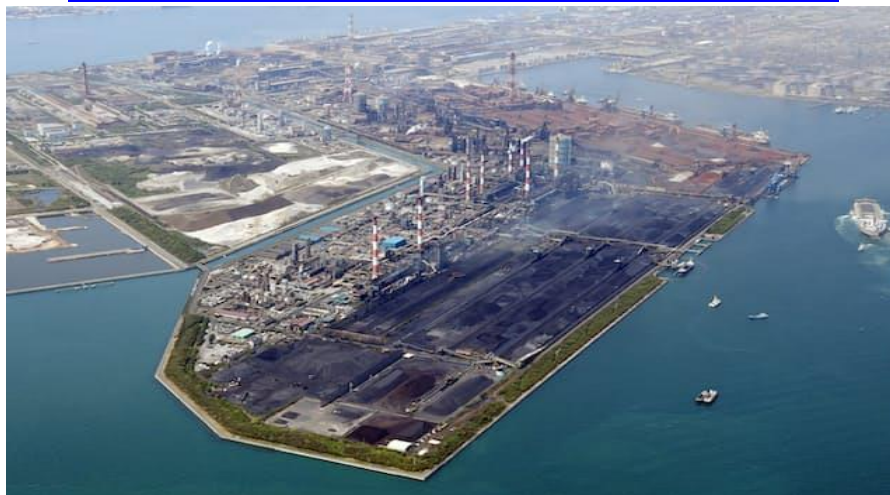
JFE は高炉 I 基を電炉に転換する方針だ (西日本製鉄所倉敷地区)
