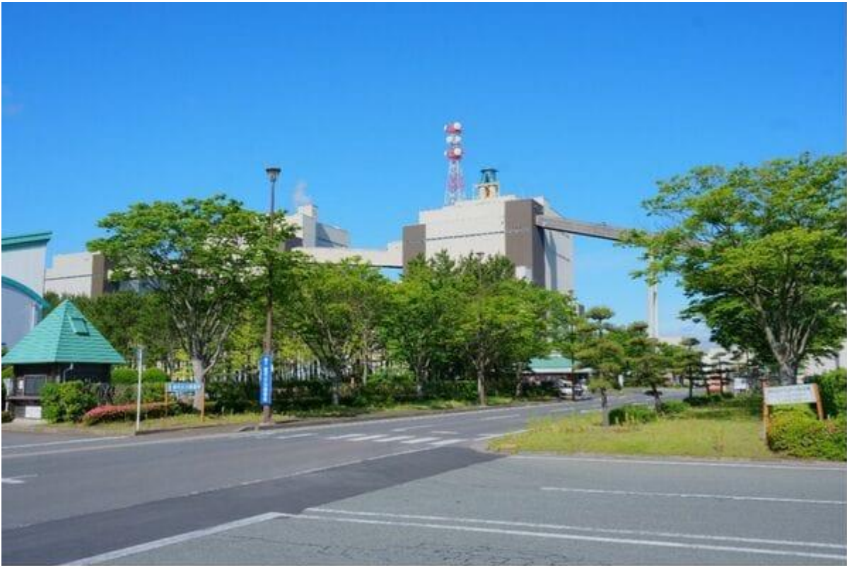
【写真3】能代火力発電所。設備容量 180 万キロワット
