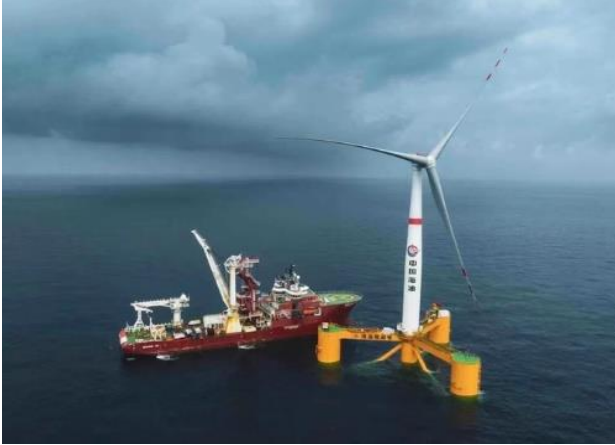
中国初の深海・遠海における浮体式洋上風力発電施設 「海油観瀾号」（資料写真）。(c)Xinhua News
