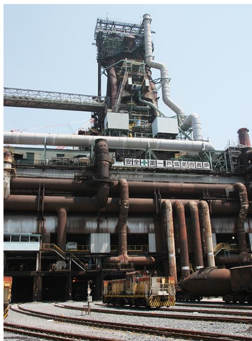
大型電炉への転換を検討している 八幡地区（北九州市戸畑区）の高炉
