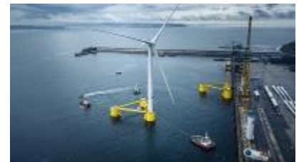
プリンシプル・パワーの浮体構造
