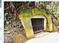
砲弾、爆弾、戦時機に装備した機銃弾が貯蔵されていたといわれています。コンクリートの壁は1mの厚みがあり、1t爆弾にも耐える構造となっています。
