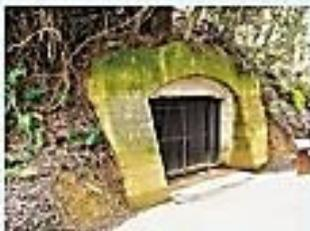
砲弾、爆弾、戦闘機に装備した機銃弾が貯蔵されていたといわれています。コンクリートの壁は1mの厚みがあり、1t爆弾にも耐える構造となっています。
