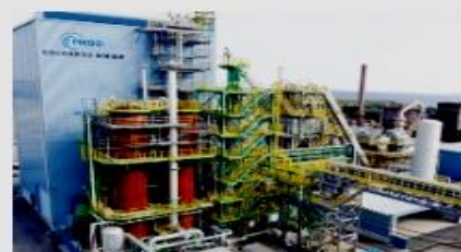
図2 高炉を用いた水素還元技術 水素による鉄鉱石の還元は吸熱反応を伴う。 (出所：水素製鉄コンソーシアム)
