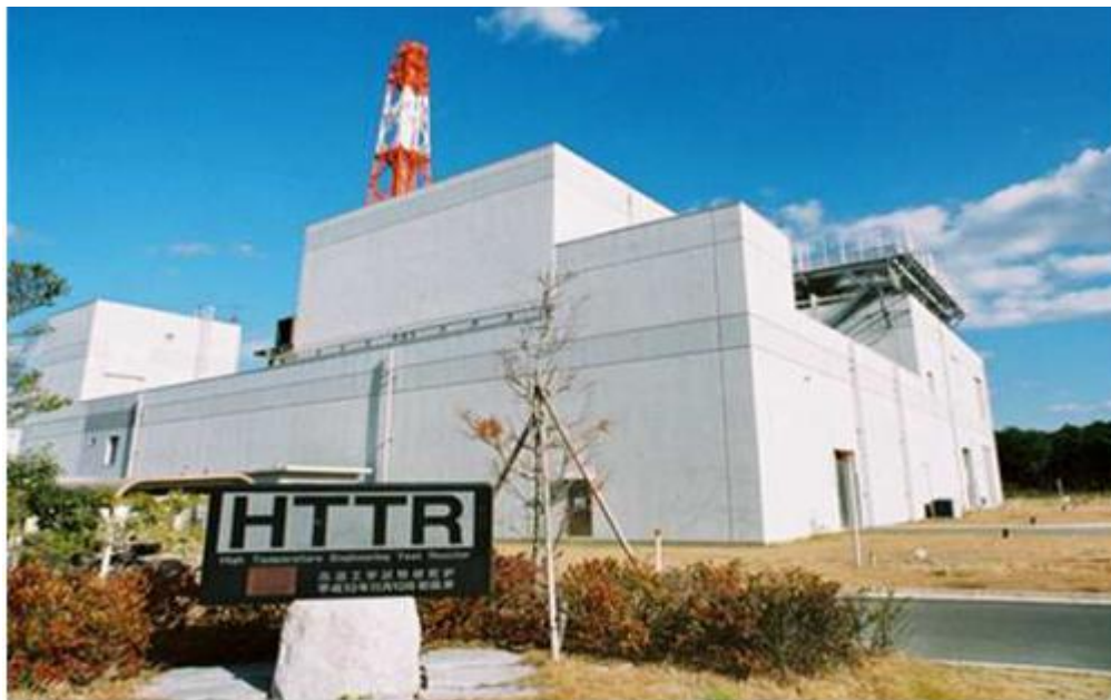
図2 HTTR (高温工学試験研究炉)
